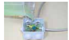
Vierta el fluido mezclado dentro de la caja hasta que esté lleno
