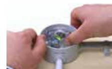
Cubra las conexiones, prestando atención no dejar áreas de vacío entre los contactos
