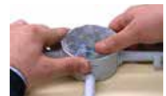
Deje un excedente de gel para obtener una perfecta adhesión con la tapa
