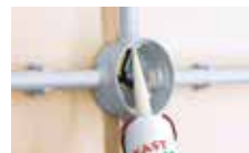
Si no utiliza prensaestopas, cierre todas las entradas de cable con sellador, para evitar la dispersión del producto
